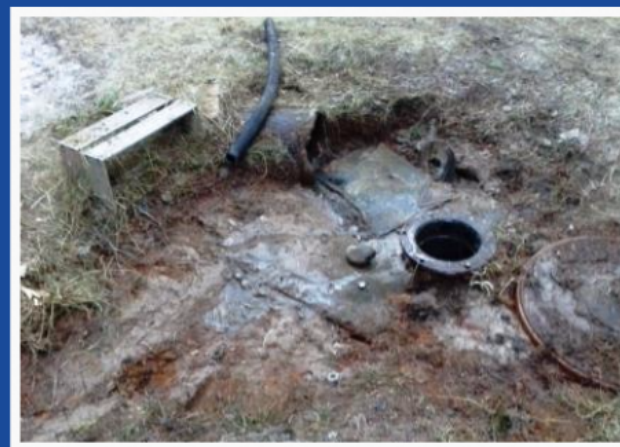
Промежуточный этап (устранение изливов и закоронных перетоков)
